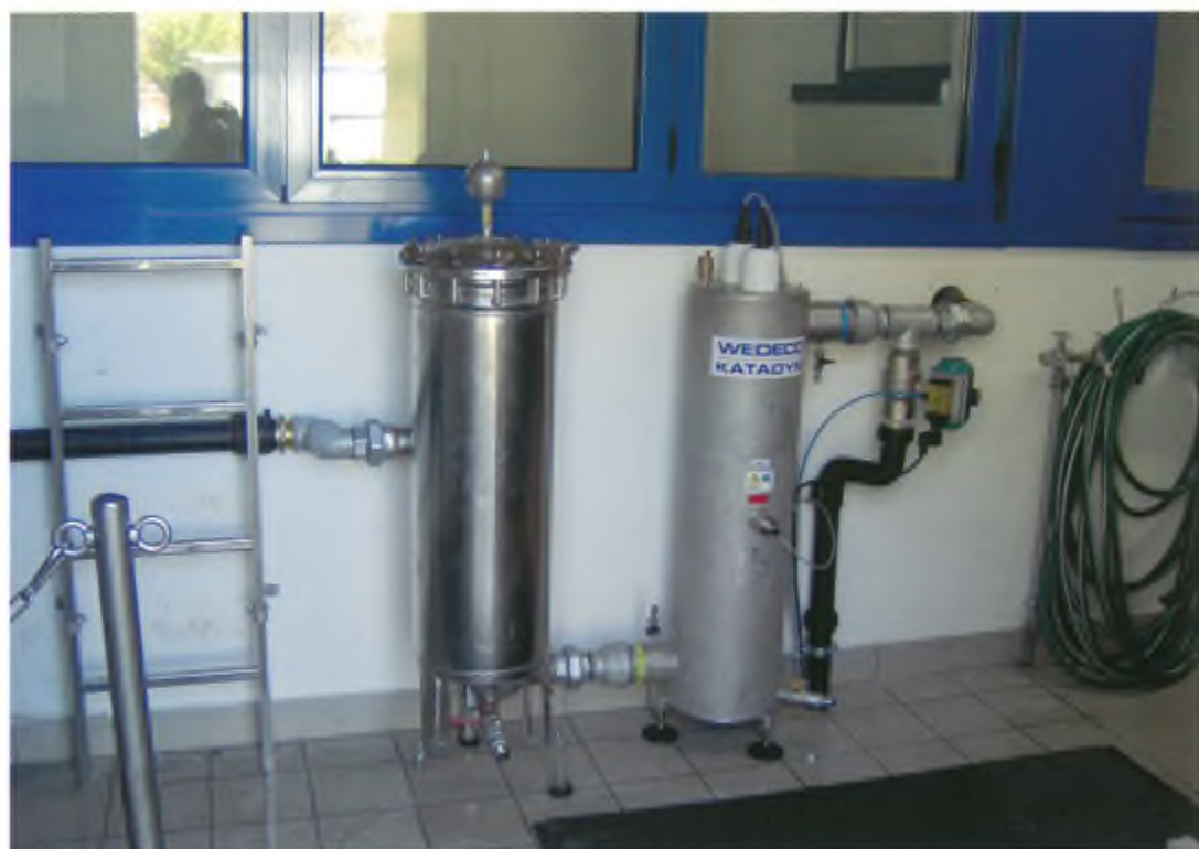
L'impianto di disinfezione mediante apparecchio a raggi ultravioletti installato nel serbatoio di Bugaro. (Foto: Candido Scettrini)
