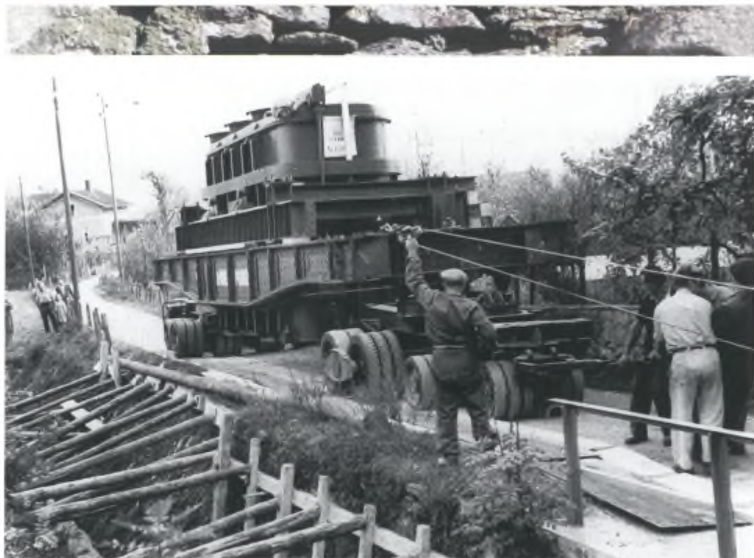
Sulla strada che dalla stazione conduce alla Cantonale vengono eseguiti dei lavori di rinforzo per sostenere l'enorme carico.
