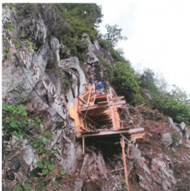
Nelle immagini i lavori di sottomurazione dei blocchi instabili.
