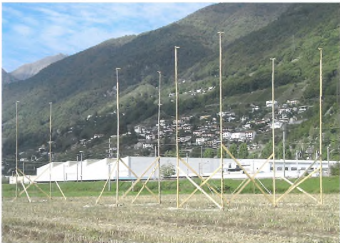
Impianto di betonaggio: modinatura vista sud.
