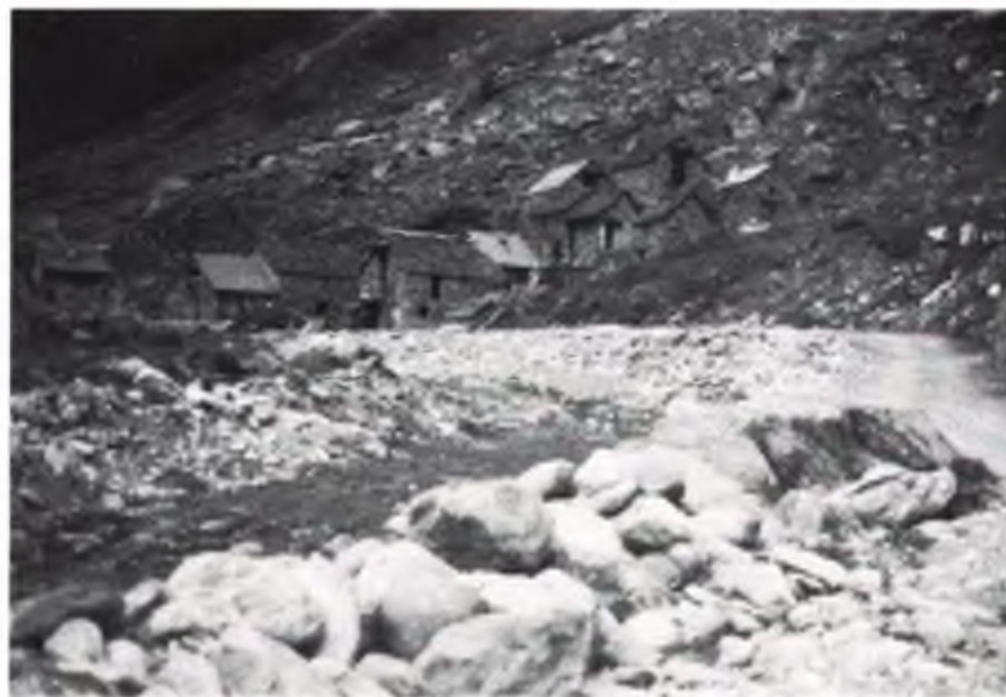
2. Cabioli: sistemato il greto del fiume e costruiti i ripari sulla strada. (foto 2 e 3)
