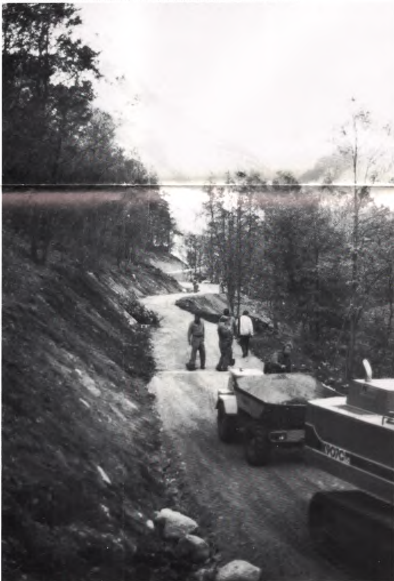
Qui sotto: la strada forestale sul Monte Valdo e sopra, la riparazione dello sbocco di un ruscello.
