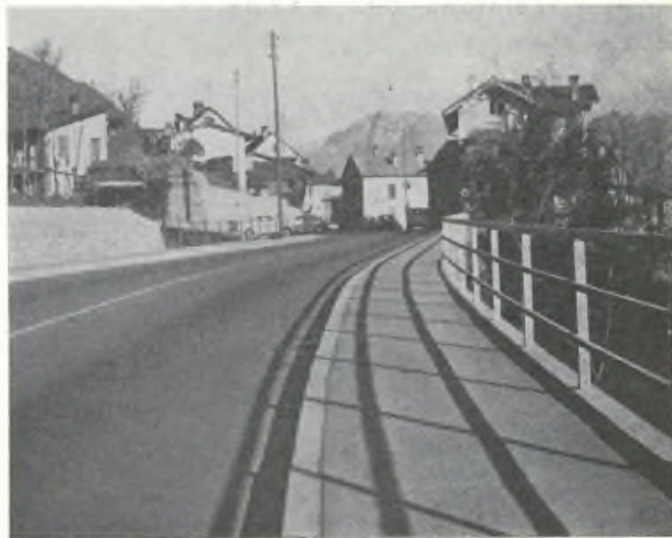
Gordola si rinnova! Demolite stalle e vecchie case, sbancata la roccia e formato un ampio posteggio., ecco come si presenta oggi l'entrata ovest.
