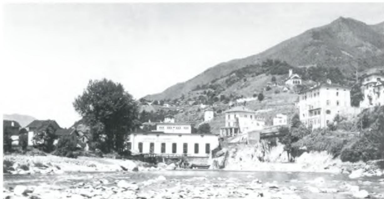
Tenero: La zona dell'Officina Idroelettrica V. V. della città di Lugano diversi decenni fa.
