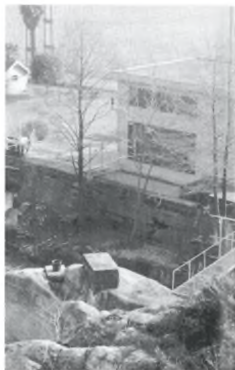
Tenero. In primo piano si scorge un manufatto in cemento e accanto un supporto in metallo.
